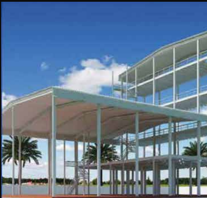
KLEAN LUBE LLC, RAS AL KHAIMAH
